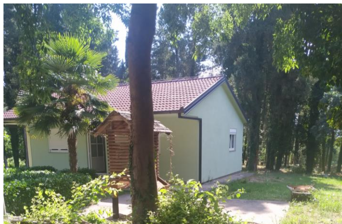
Slika 4.1.4.1. upravna zgrada, Karaotok – postojeći objekt predviđen za rušenje
