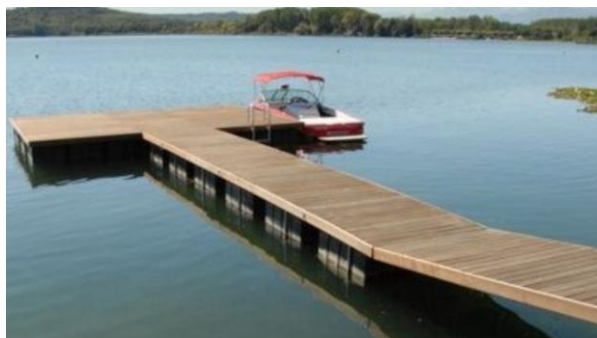
Slika 4.1.7.1. zglobno pristanište za brodice, primjer
