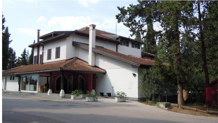
Slika 4.1.3.1. Hotel Park, Karaotok – postojeće stanje
