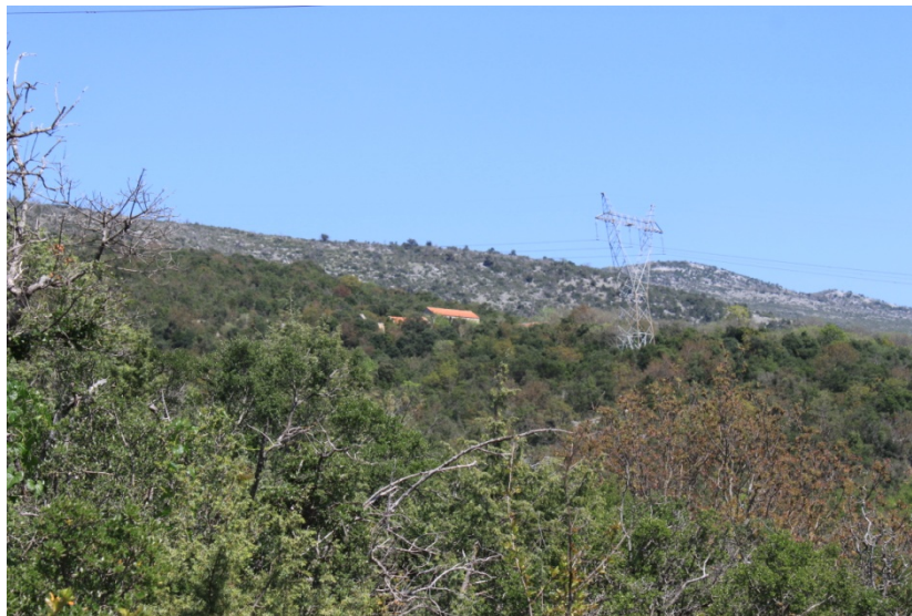
Slika 29. Visokonaponski dalekovodi u stolačkoj općini
