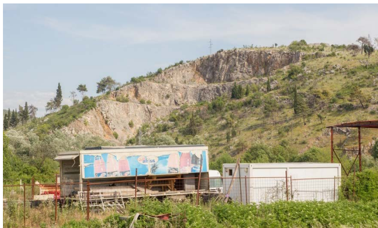
Slika 32. Napušteni kamenolom na glavnom ulazu u Park – pogled s magistralne ceste M17
